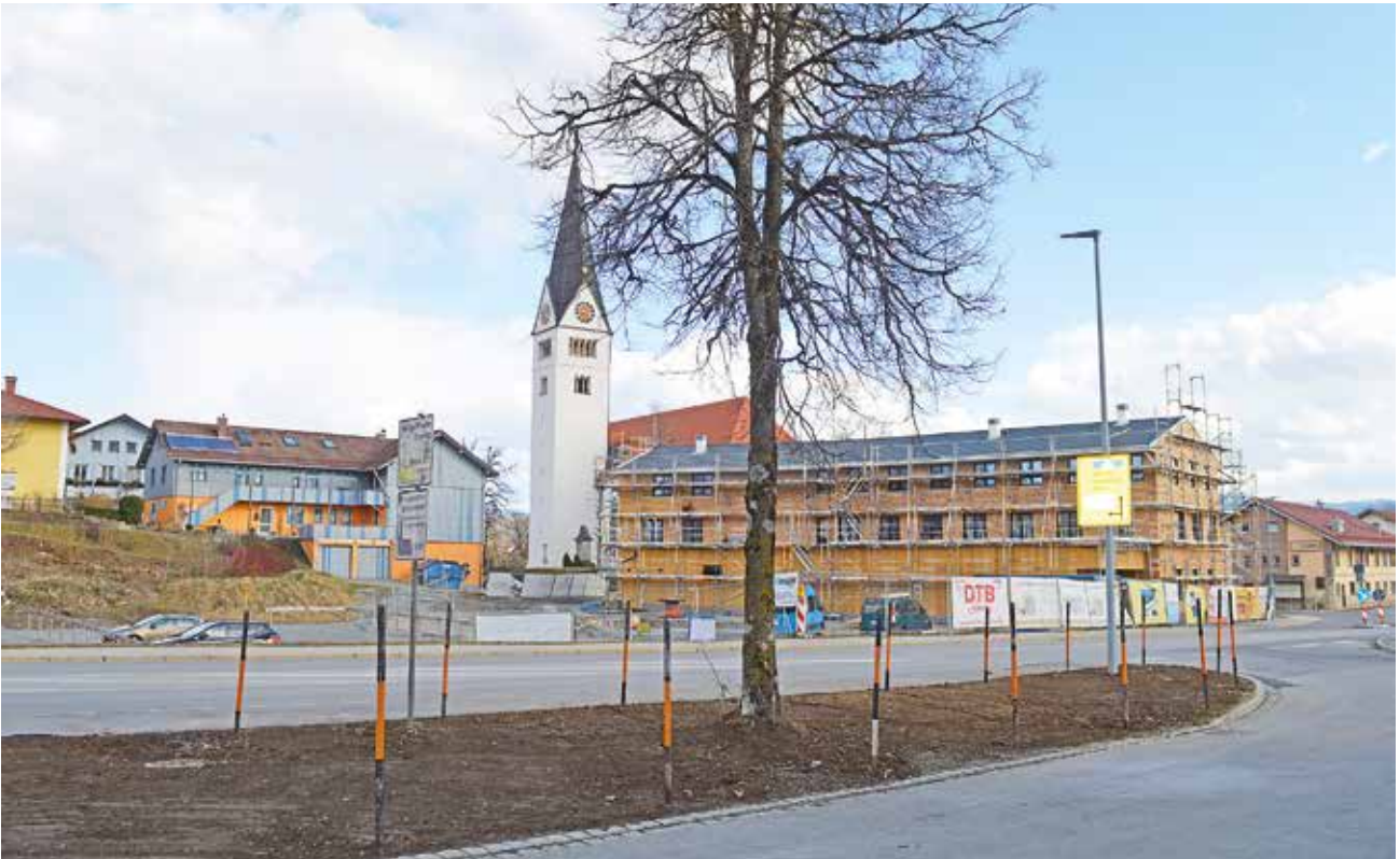
Das von der Raiffeisenbank Kempten-Oberallgäu eG gebaute und von der Lebenshilfe Kempten angemietete Gebäude liegt mitten in Waltenhofen. Einkaufsmöglichkeiten sind zu Fuß erreichbar, eine Bushaltestelle liegt direkt vor dem Haus (Blick von der Eingangstür des Wohngebäudes).
